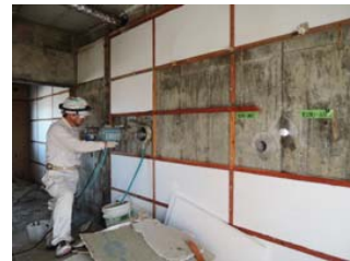
コア抜き調査
