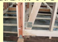
耐震補強工事の例
