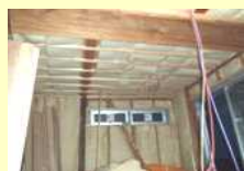
外壁断熱工事の例
