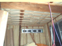
外壁断熱工事の例
