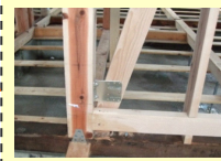
耐震補強工事の例
