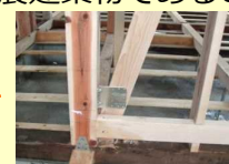
耐震補強工事の例
